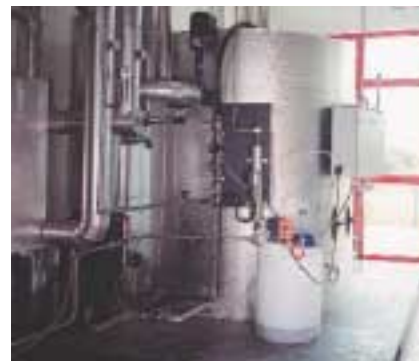
LOOS-Wasserservicemodul WSMV zur Speisewasserversorgung und Abwasserentsorgung
