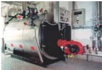
LOOS-Dampfkessel der neuesten Generation UNIVERSAL U-HD
