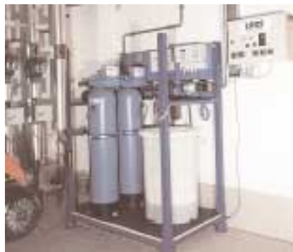
LOOS-Wasserenthärtungsmodul WEM-DQ für qualitätsgesteuerte Weichwassererzeugung
